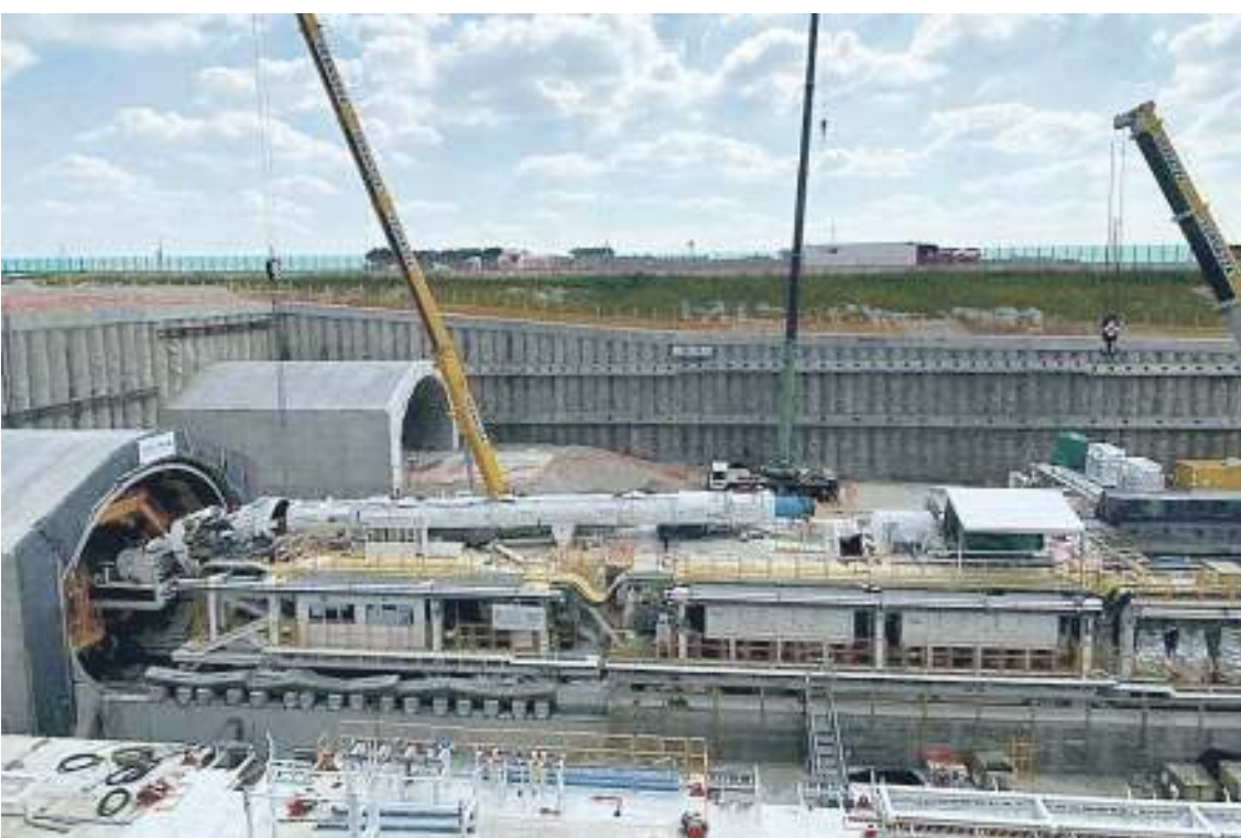
IN PIENA ATTIVITÀ Il cantiere dell'Alta velocità si trova a pochi metri dall'Acquedotto carolino
