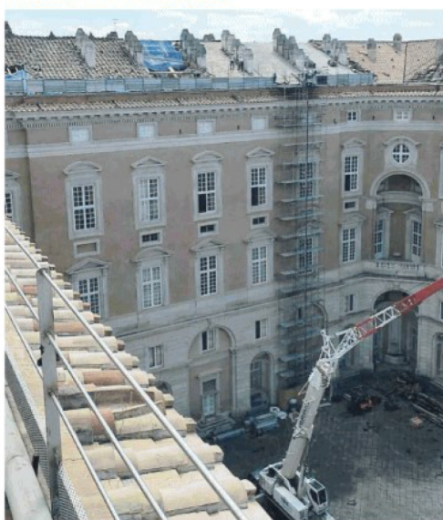
I macchinari installati nei cortili per i lavori sul tetto della Reggia
