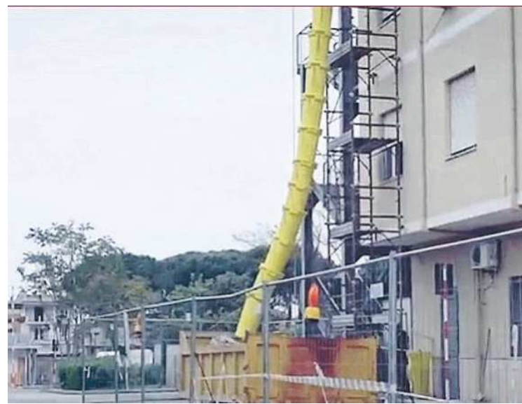
IL CANTIERE Il costo dell'operazione è di due milioni e 800 mila
